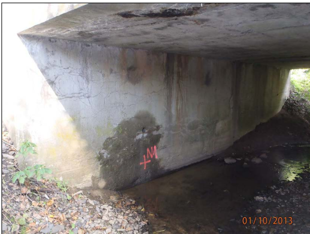
Obr. č. 3 - opěra Hustopeče, povrch opěry je bez větších poruch, lokálně je opadaný a s tenkými prasklinami
