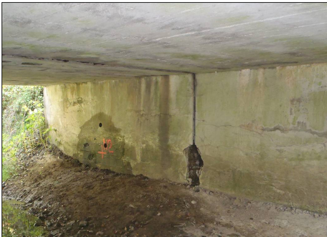
Obr. č. 4 - opěra Valašské Meziříčí, povrch opěry je bez větších poruch, lokálně je beton vypadaný do hloubky a s tenkými prasklinami
